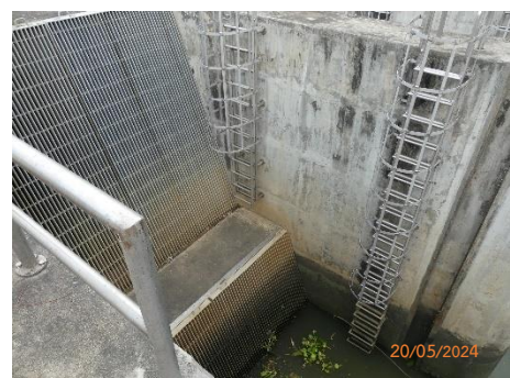
รูปที่ 2.2-19 ตะแกรงช่องรับน้ำ บริเวณสถานีสูบน้ำทำrap
