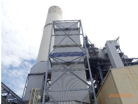
รูปที่ 2.2-4 ระบบกำจัดก๊าซ \text{SO}_2 (Flue Gas Desulfurization: FGD)
