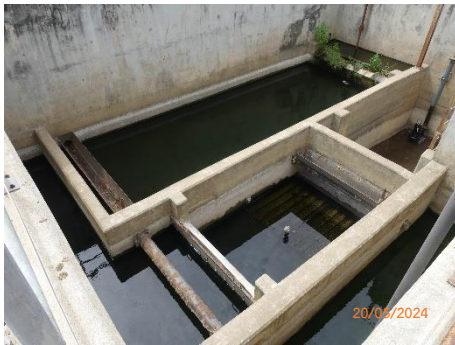
รูปที่ 2.2-22 บ่อดักไขมันจากน้ำทิ้งโรงไฟฟ้า
