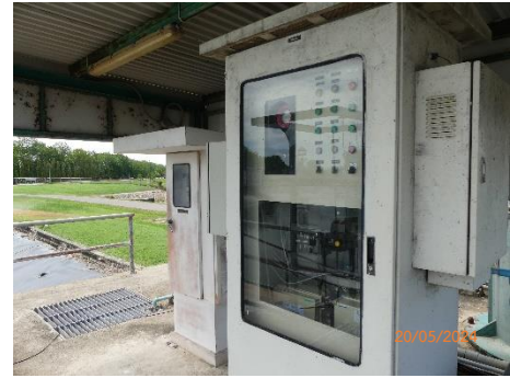
รูปที่ 2.2-10 รายงานสิ่งแวดล้อม และกิจกรรมเพื่อสังคม รูปที่ 2.2-11 เครื่อง BOD/COD Online บริเวณบ่อบำบัดน้ำเสีย
